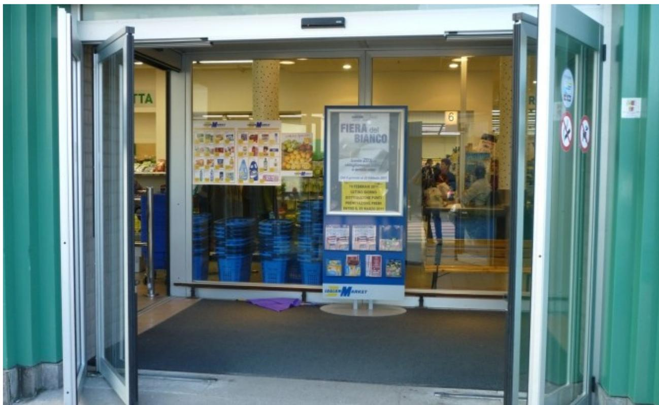
Si le système anti-panique est activé pendant le fonctionnement du système, l'automatisme enregistre automatiquement l'événement et déplace les vantaux en position d'ouverture complète afin de faciliter au maximum l'ouverture de la voie d'évacuation.
