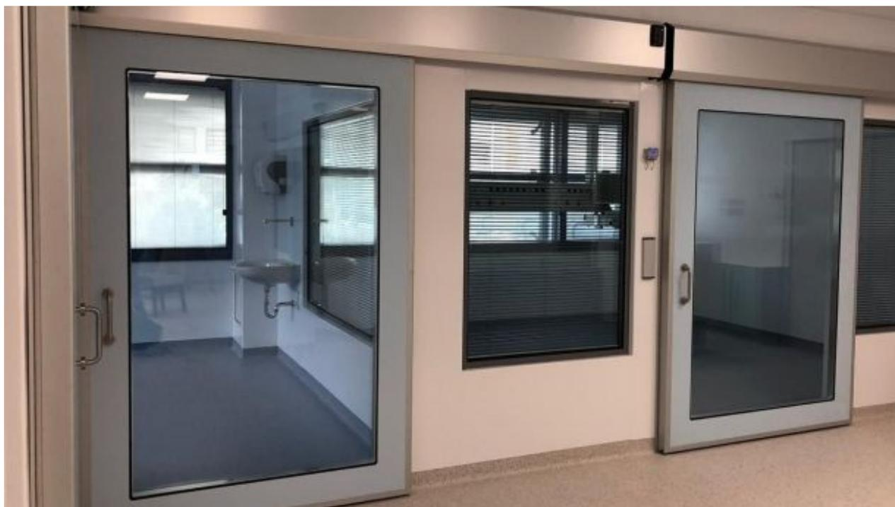
Le haut niveau d'hygiène est assuré par sa construction particulière car les bords arrondis en aluminium anodisé sont nivelés avec le panneau de porte. Cette porte hermétique résiste à la surpression ou au vide, cela assure la non diffusion des bactéries qui peuvent être causées par une fuite d'air de la porte. D'autres avantages sont la résistance à la fumée qui permet d'utiliser la porte **POLYOPEN MAROC** comme écran de séparation pare-fumée.
